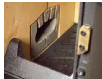
Fig.: Chambre de combustion des bûches avec tunnel à flamme des pellets latérale
